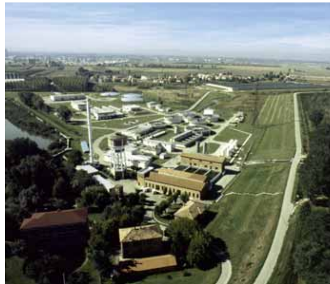
Visione aerea centrale di Pontelagoscuro
