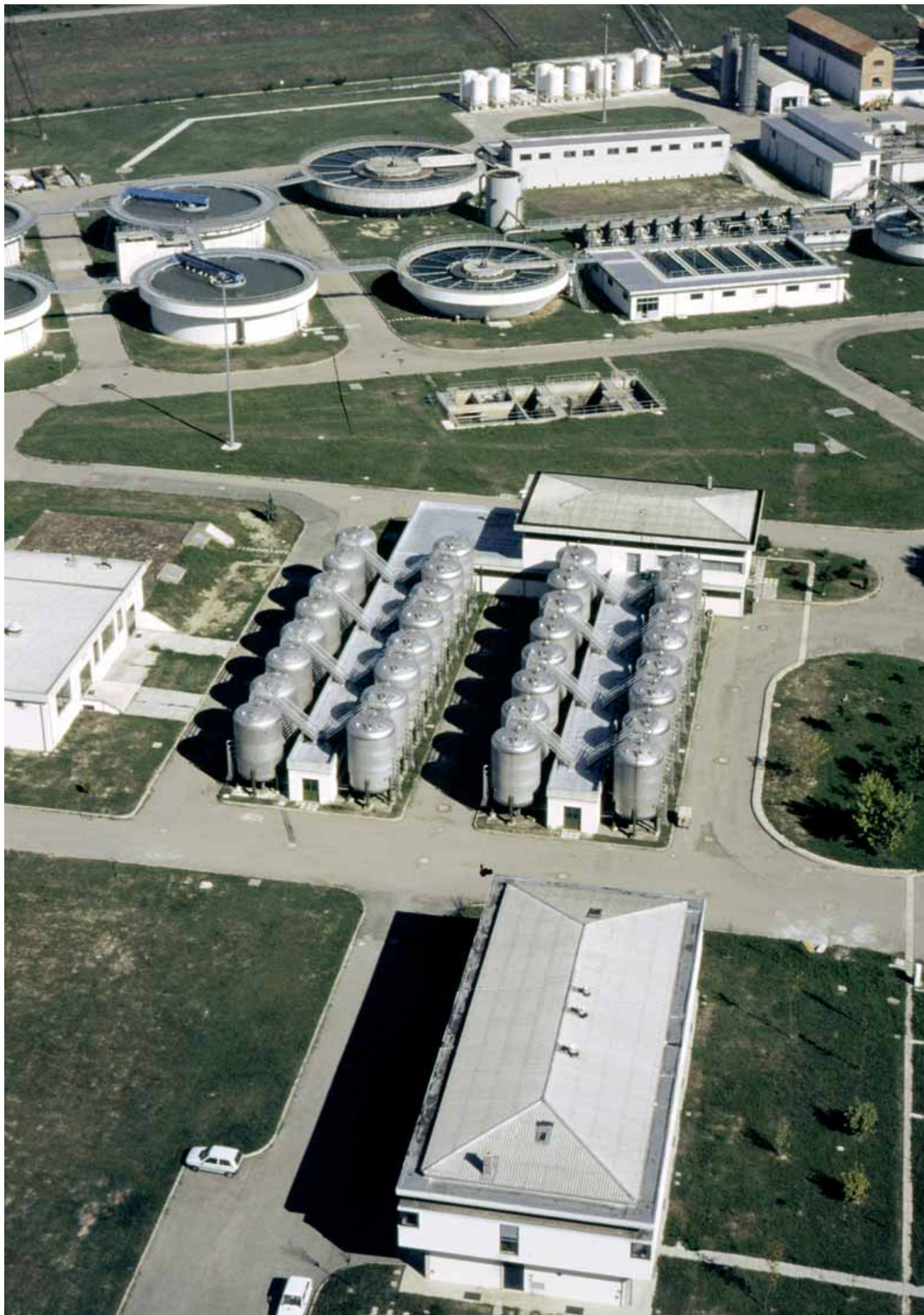
Foto aerea impianti di filtrazione a carboni attivi
