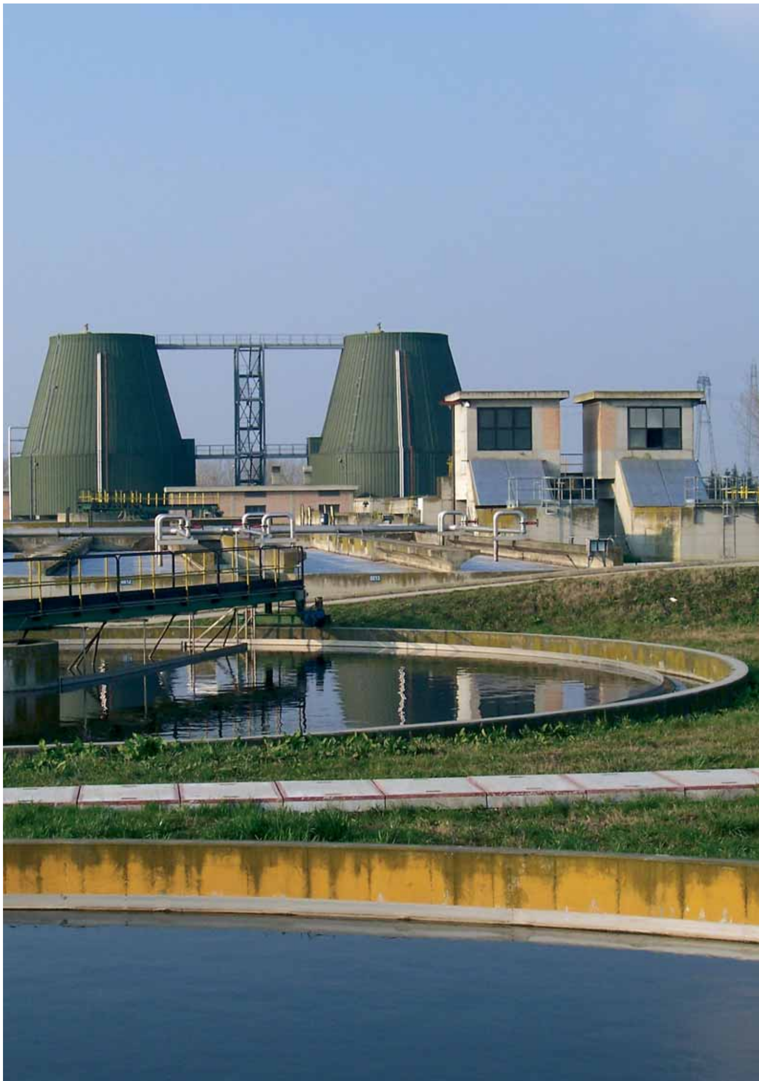
Impianto di depurazione
