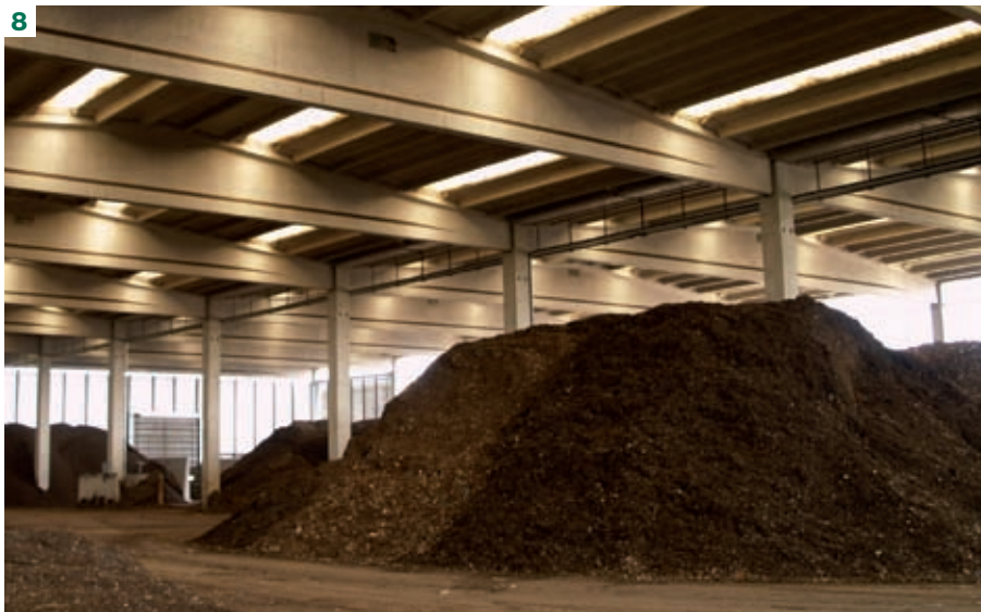
8 - Impianto di compostaggio di Voltana (RA)
