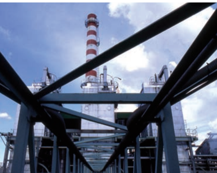
6 - Il camino di un termovalorizzatore
