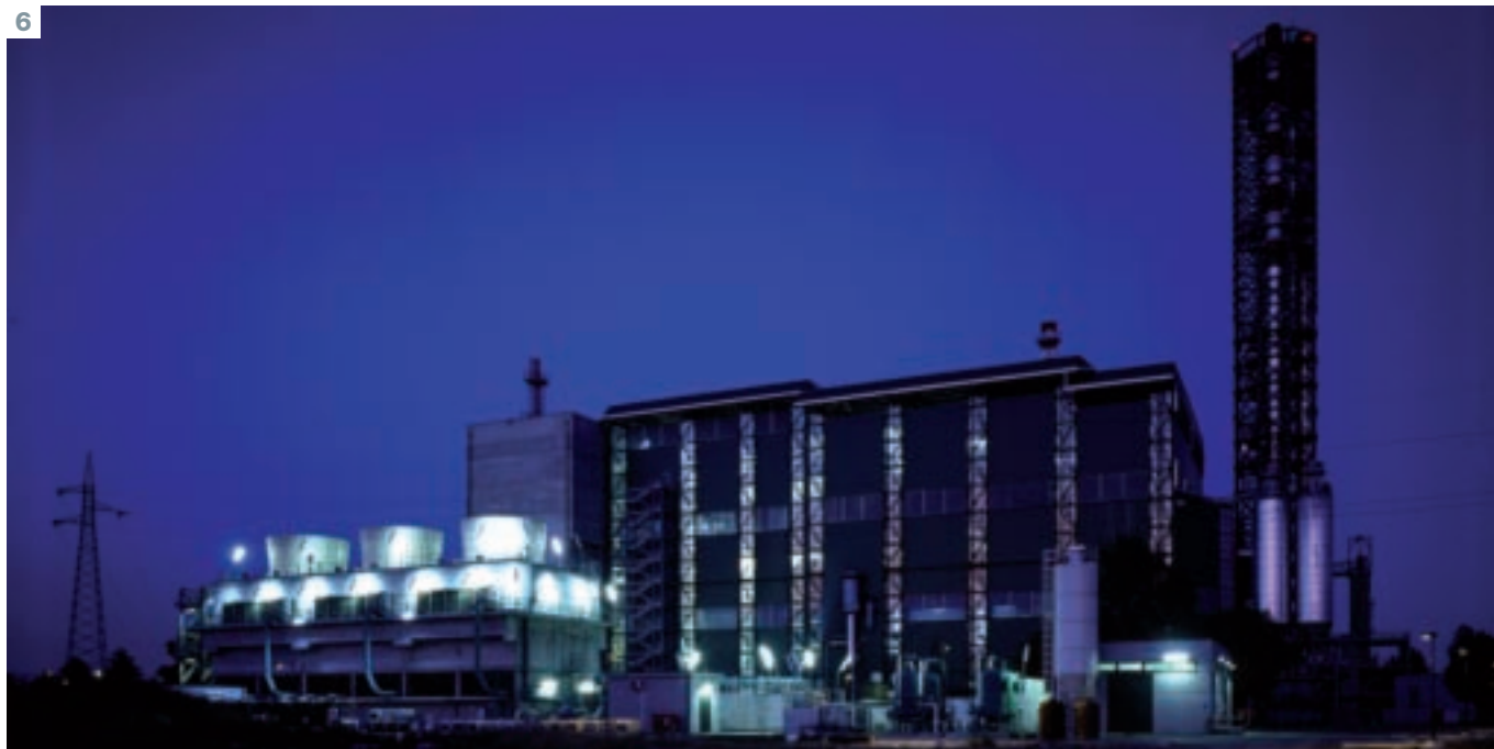
6 - Impianto di termovalorizzazione Bologna / Bologna plant
