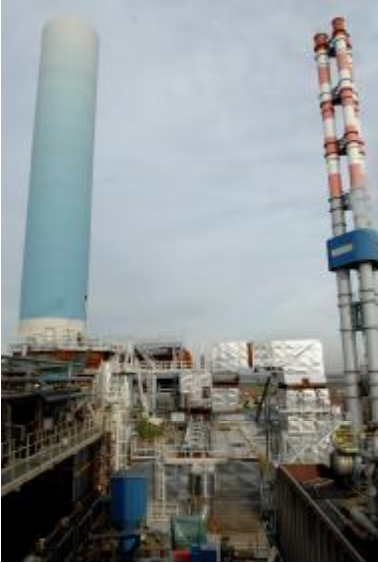
Esterno dell'impianto WTE di Modena
