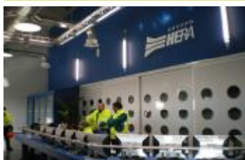
Interno del WTE di Modena
