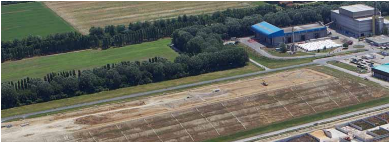
Veduta aerea Comparto Hermbiente Ravenna SS Romea Aerial view of Hermbiente Ravenna SS Romea sector
