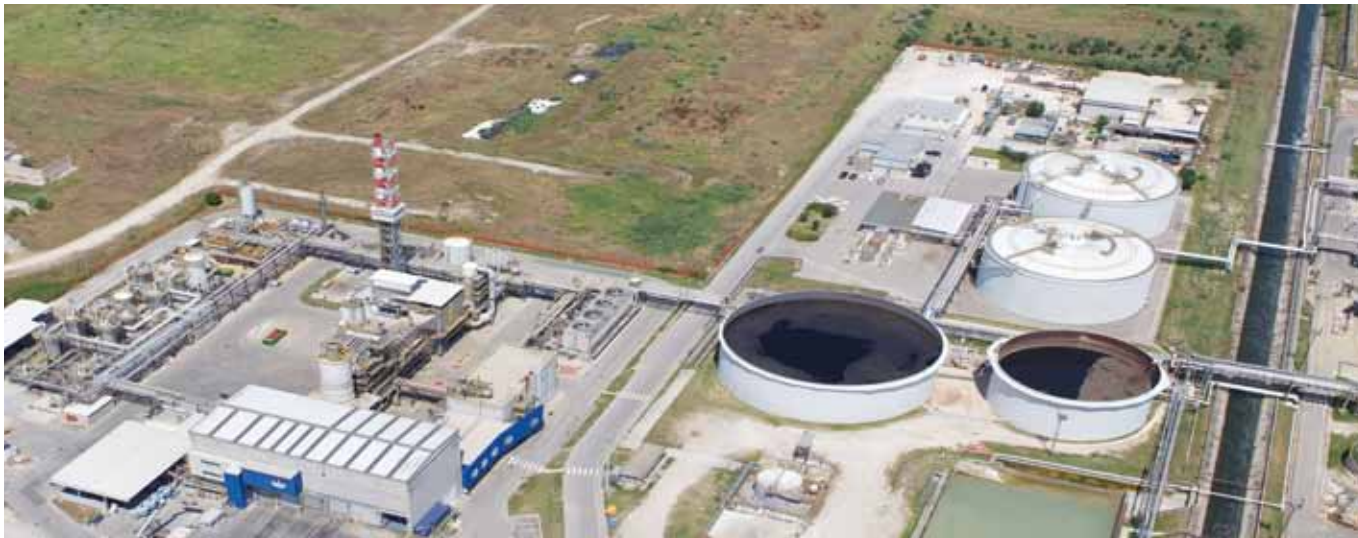
Veduta aerea della piattaforma integrata per il trattamento di rifiuti speciali (Ravenna) Aerial view of the integrated platform for treatment of special waste (Ravenna)
