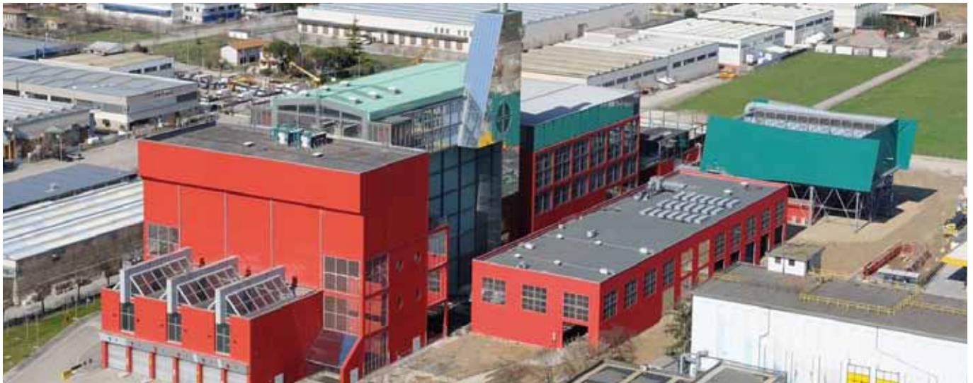
Termovalorizzatore di Forlì, veduta aerea del comparto di Via Grigioni Forlì WTE, Aerial view of Via Grigioni sector
