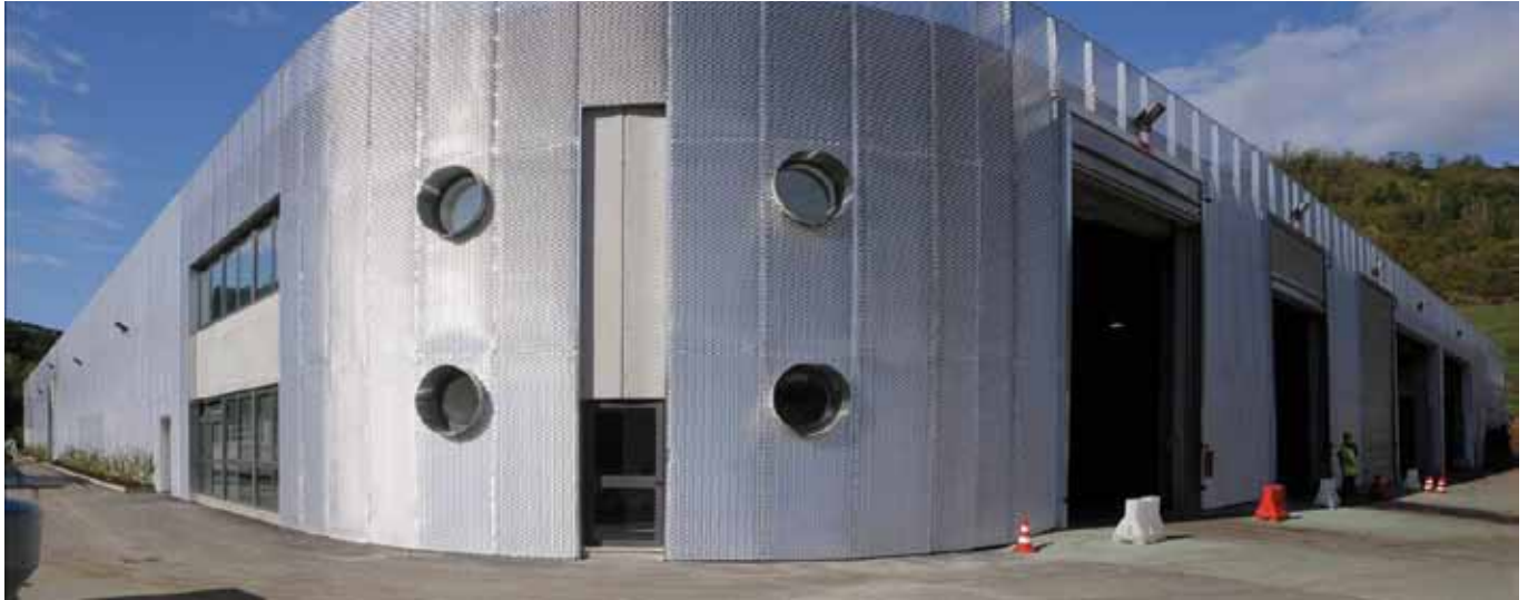
L'impianto di Romagna Compost (Cesena) Romagna Compost plant (Cesena)
