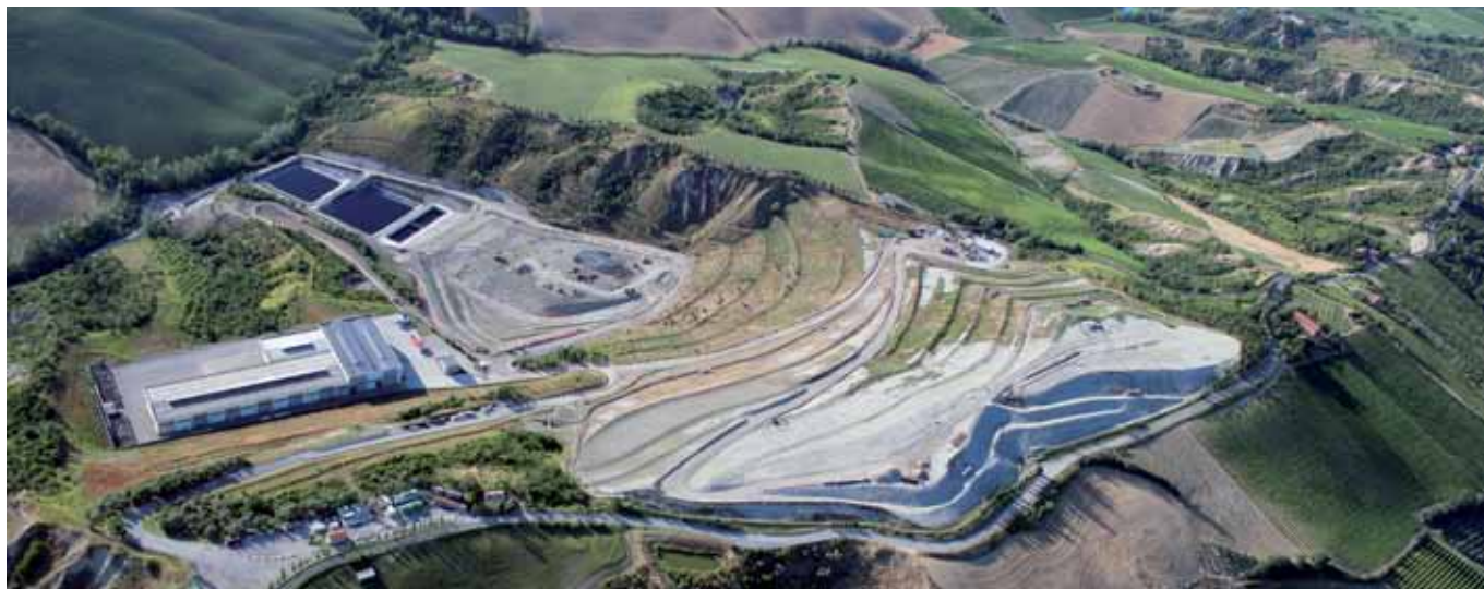
Veduta aerea della discarica di Tre Monti, in località Pediano di Imola (Bologna) Aerial view of Tre Monti landfill, Pediano di Imola (Bologna)
