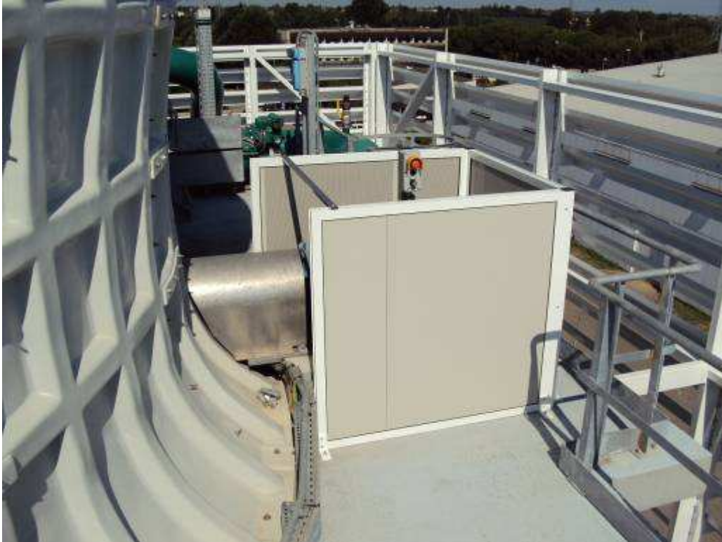
Fig 17: Installazione della cofanatura sul motore dei ventilatori della torre evaporativa
