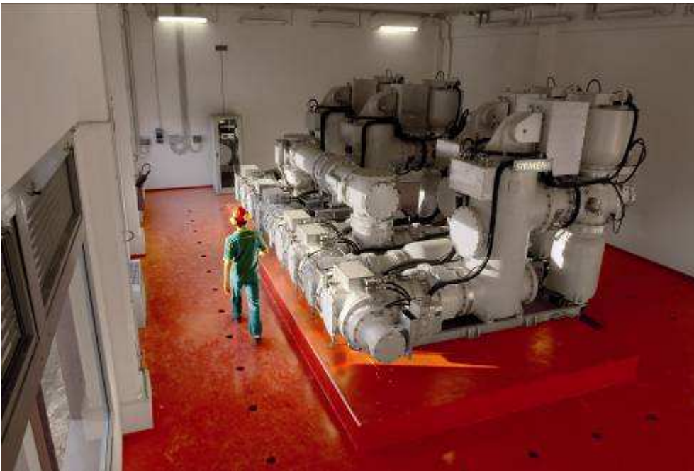
Fig. 11 Vista dall'alto del sistema blindato isolato in gas SF 6
